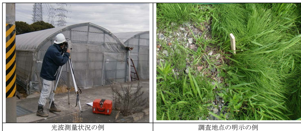
図 4-6 位置出し測量状況の例
