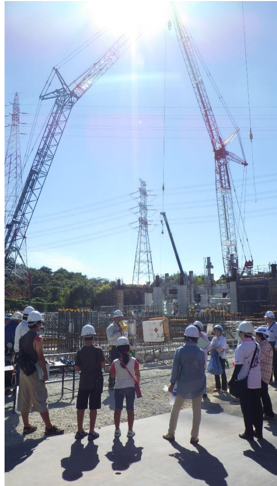
大きなクレーンの高さにびっくり！
