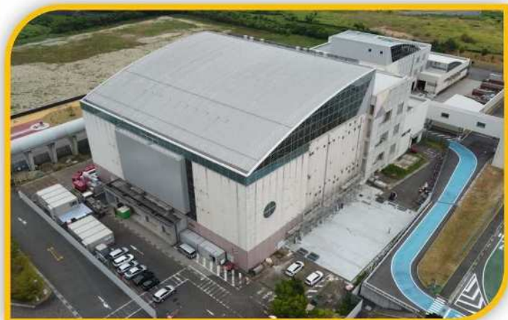
RDF化施設棟 (令和6年8月)
