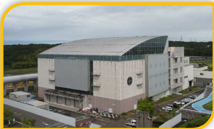
RDF化施設棟 (令和6年6月)
