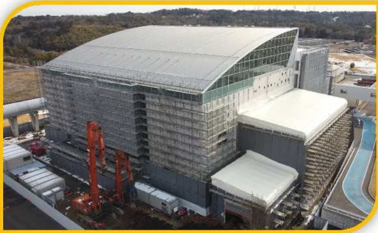
RDF化施設棟 (令和7年2月)
