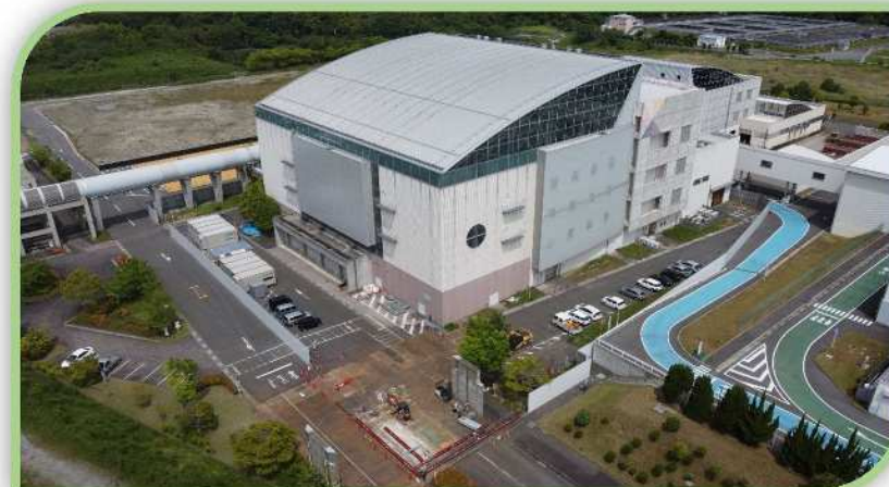
RDF化施設棟 仮囲いの設置 (令和6年5月)
