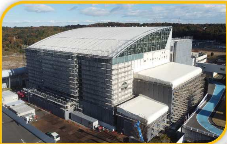
RDF化施設棟 (令和6年12月)
