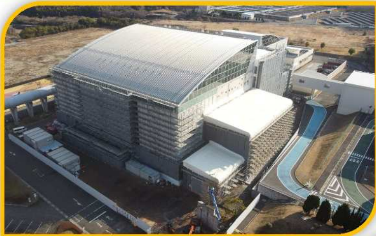
RDF化施設棟 (令和7年1月)
