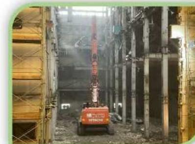
プラント設備解体工事では、大型の重機を使って各階の設備や梁の解体を行っています。
