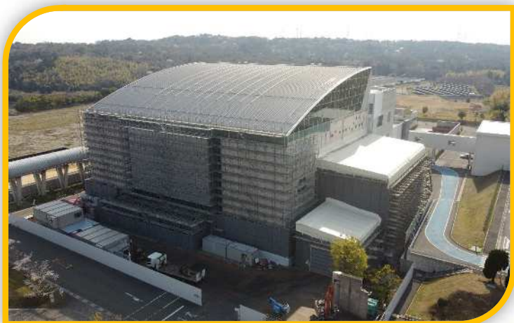
RDF化施設棟 (令和7年4月)
