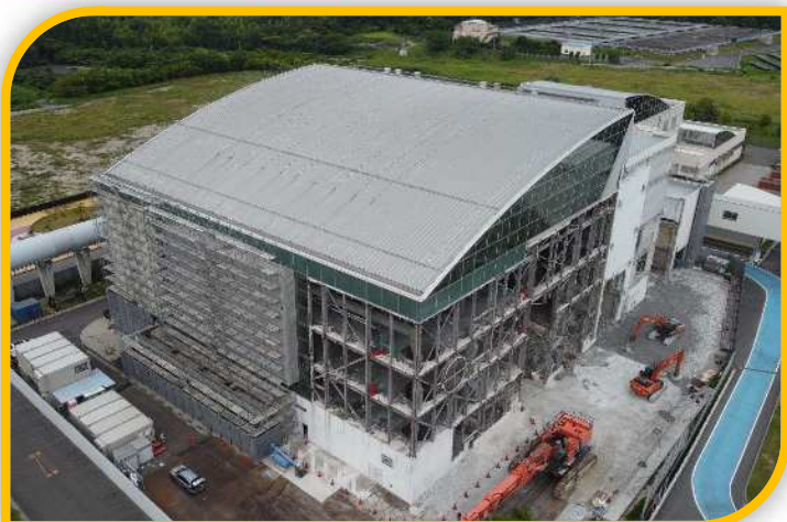
RDF化施設棟 (令和7年6月)
