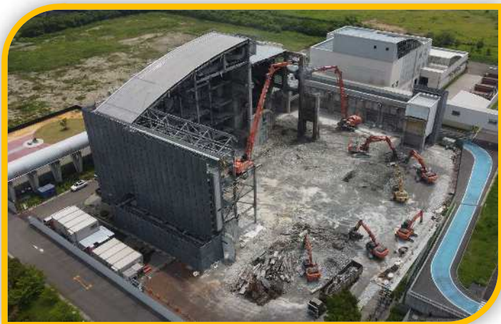
RDF化施設棟 (令和7年7月)
