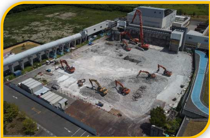
RDF化施設棟 (令和7年8月)
