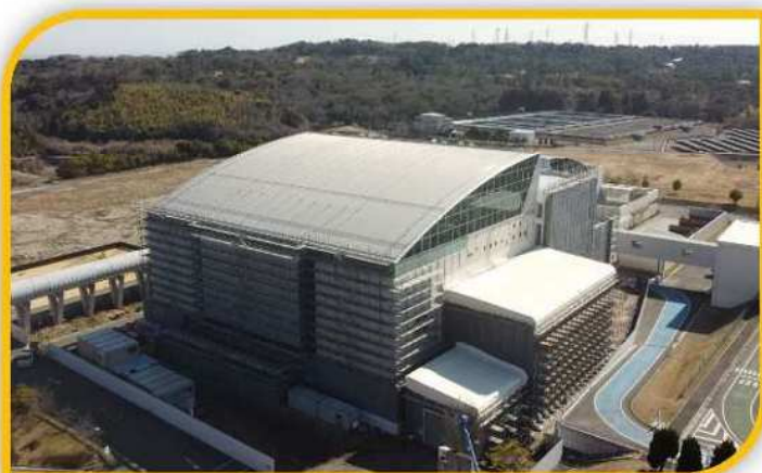
RDF化施設棟 (令和7年3月)
