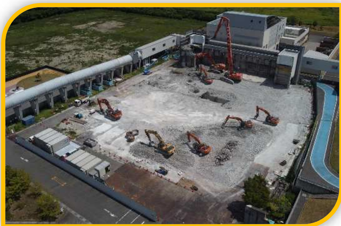
RDF化施設棟 (令和7年8月)
