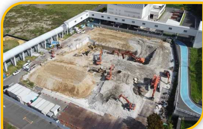
RDF化施設棟 (令和7年10月)
