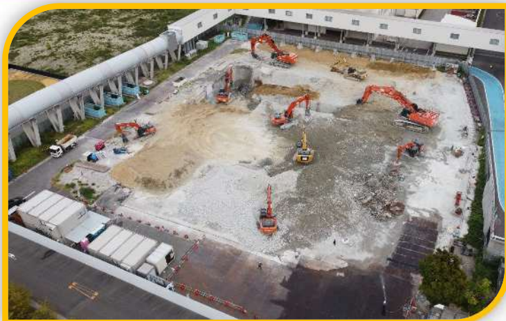
RDF化施設棟 (令和7年9月)
