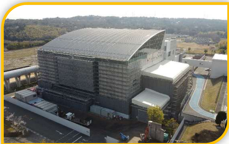
RDF化施設棟 (令和7年4月)
