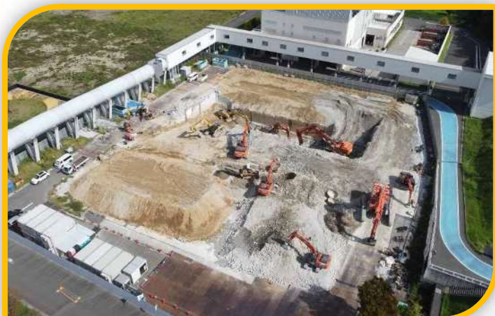
RDF化施設棟 (令和7年10月)
