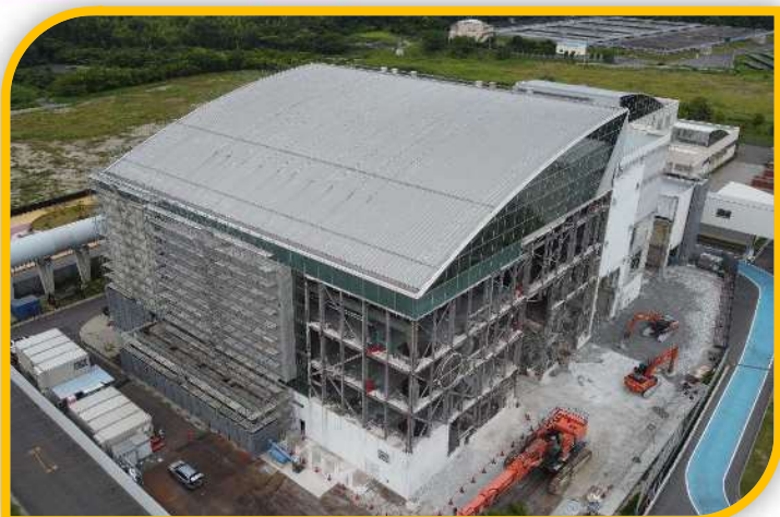
RDF化施設棟 (令和7年6月)
